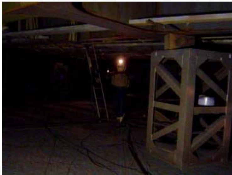
圖5 噴砂工人佩戴供氣式防護頭罩即將進入板材(block)內部進行噴砂
