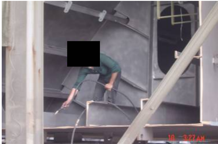
圖7 噴砂工人噴砂後之吹砂作業
