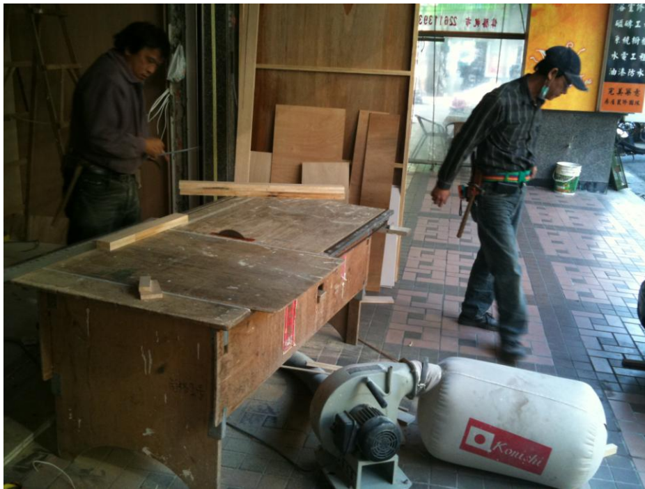
圖 21 木工作業現場使用之集塵機與濾袋
