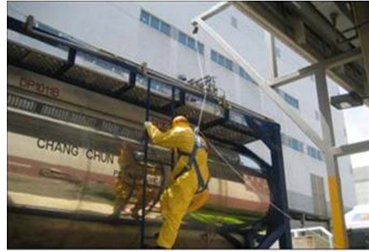
圖 3.13 增設槽車灌充人員防墜器
