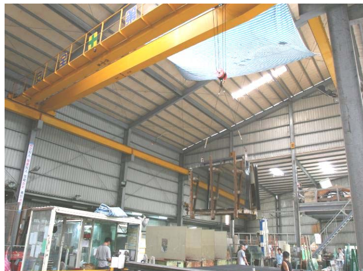
圖 63 固定式起重機運轉時未規劃安全區域.
