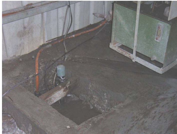
圖 75 鑽孔機污水處理改善措施.
