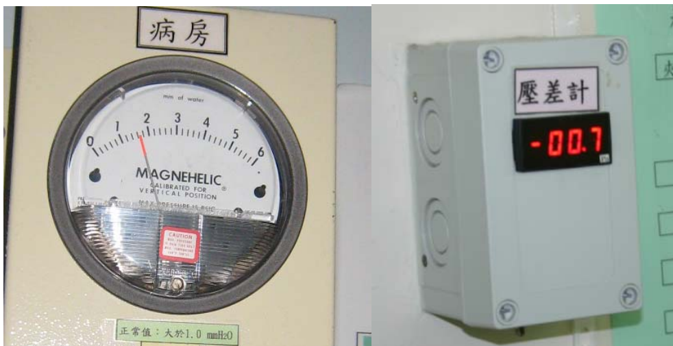
圖3 常見的儀表型微壓差計（左：類比機械式，右：數位電子式）
