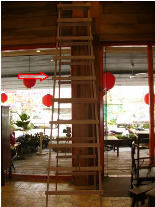
(a)罹災者站在木質合梯高約 2.2 公尺之第 6 階處，修補高約 3.2 公尺之木壁板。(模擬災害發生時狀況)
