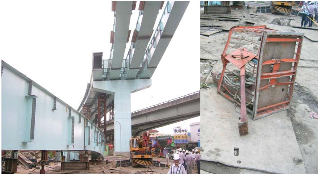
圖 27 從事安全施工步道作業搭因吊籃與吊桿接合處斷裂導致墜落死亡
