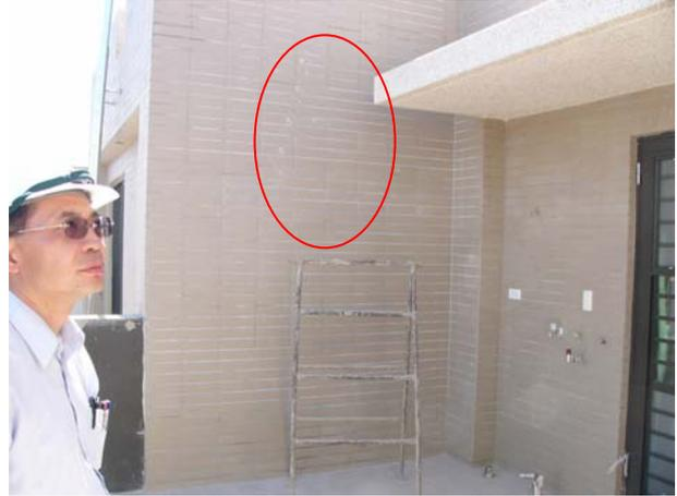
(b)牆面汗漬分佈於高度 1.8 公尺處至高度 2.8 公尺處(紅色圈圈處)
