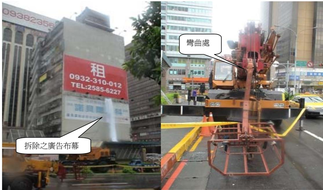
圖 26 從事廣告布幕拆除作業因伸臂連結桿彎曲無法荷重導致墜落死亡
