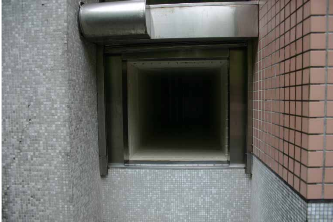
圖20 拆除多餘的整流片，修平風洞出口底部的傾斜突出部位
