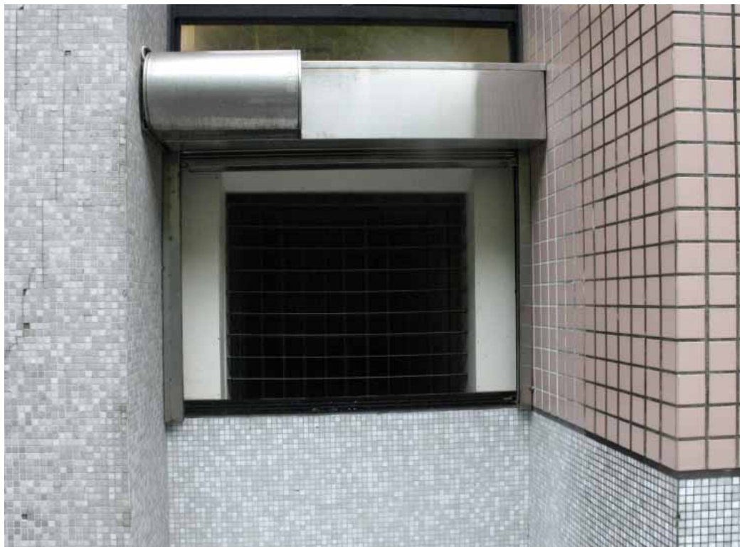
圖17 吸氣式開迴路風洞：出口修改前外觀（自戶外拍攝）
