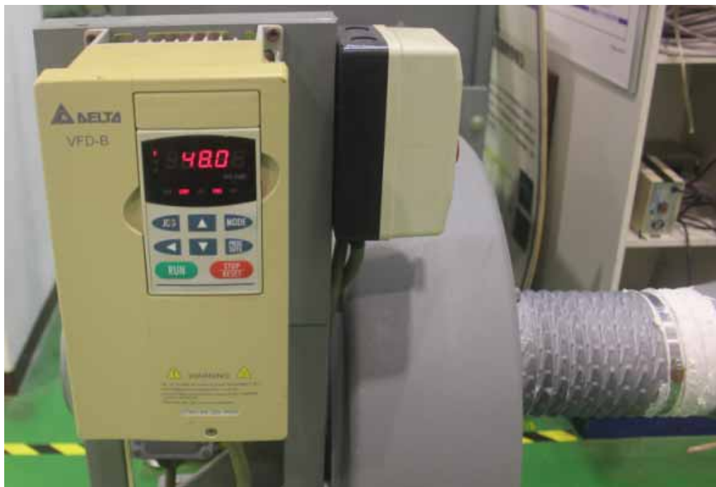
圖37 控制離心排氣機轉數的可程式變頻器
