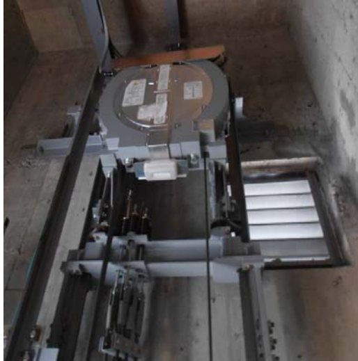
圖 66 薄型的圓盤狀無齒輪馬達
