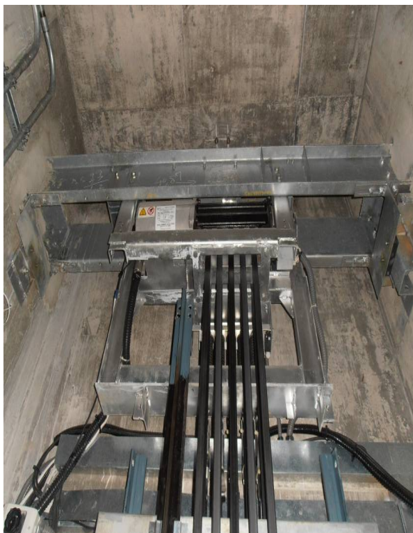
圖 74 馬達安裝所在的橫梁以貫穿牆壁來支撐
