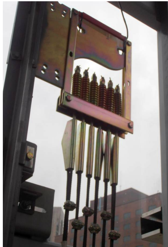
圖 43 車廂端的鋼索鎖定到升降機的導軌上
