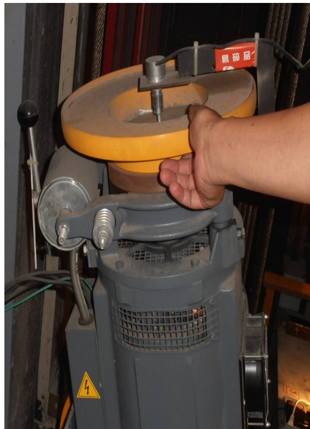
圖 61 可利用馬達上的把手解除剎車
