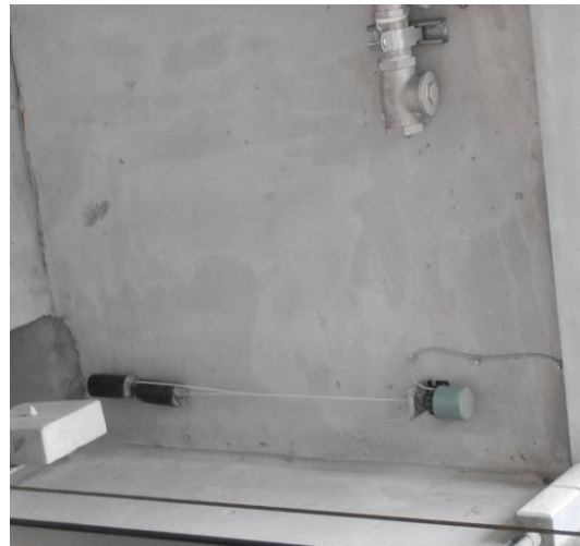
圖 45 機坑裝有淹水感測器
