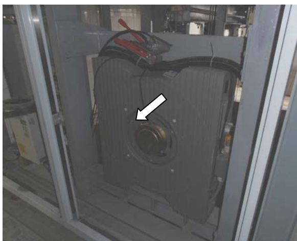
圖 20 薄型的圓盤狀無齒輪馬達
