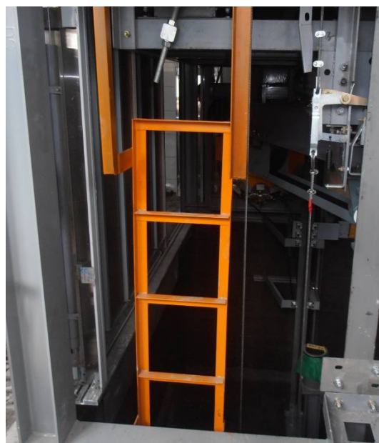
圖 23 設置永久性鋼梯
