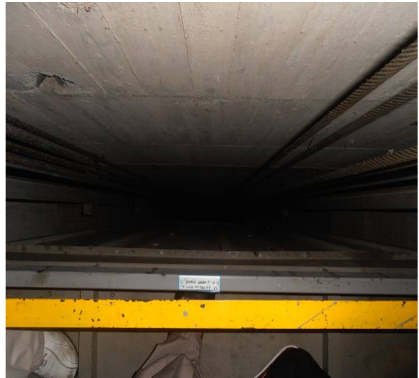
圖 51 車廂與升降路間間隙頗大
