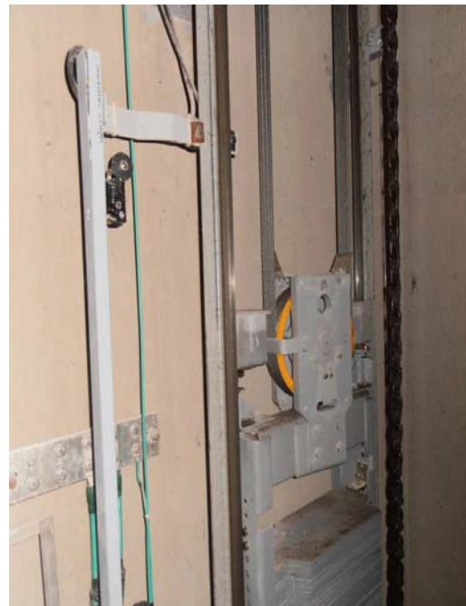
圖 69 懸吊配重滑輪旁的鏈條
