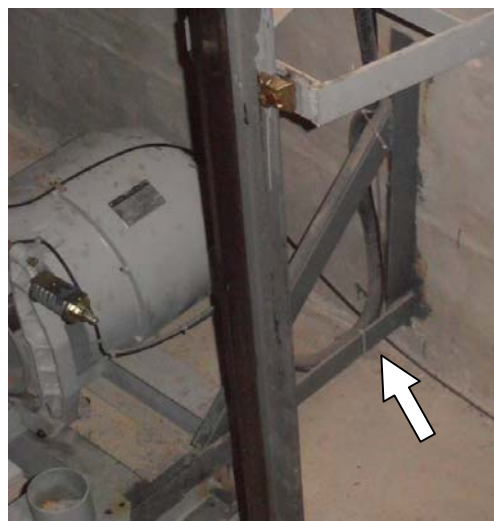
圖 53 固定到牆上的角鋼架
