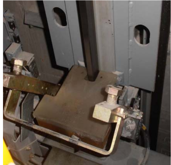
圖 71 鋼結構鎖定裝置
