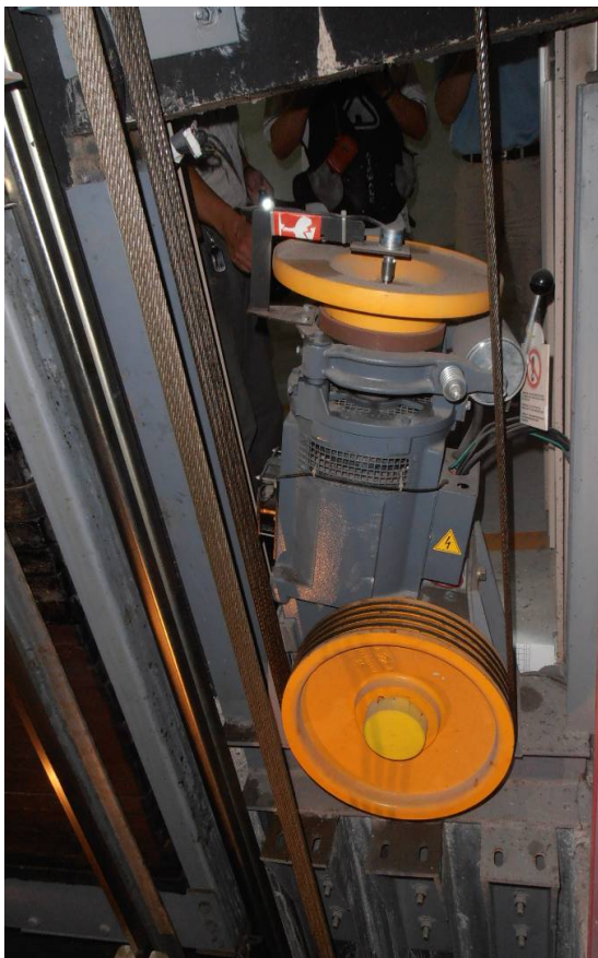
圖 60 有齒輪變速箱的馬達與槽輪
