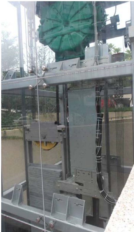
圖 42 馬達與懸吊配重的滑輪
