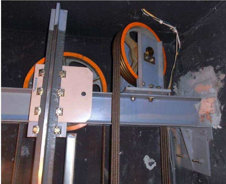
圖 65 頂部支撐轉向滑輪的橫梁固定到升降路牆壁中
