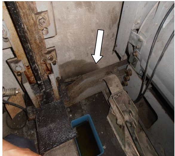
圖 47 在馬達槽輪端加上強化橫梁
