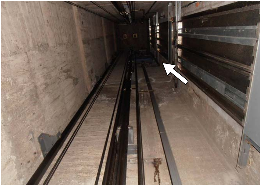
圖 28 捲揚機設置在靠近最高樓層
