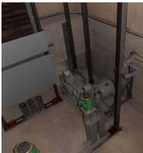
圖 52 馬達安裝在機坑底部地板
