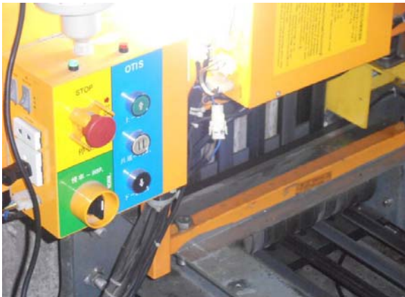
圖 78 工作平台上有控制車廂移動在控制箱
