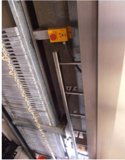
圖 82 鋼梯上方有一緊急煞停車廂的控制箱
