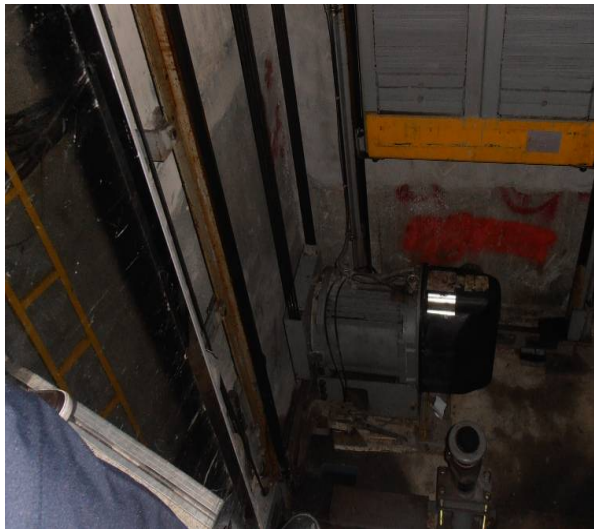
圖 46 馬達安裝在機坑底部地板
