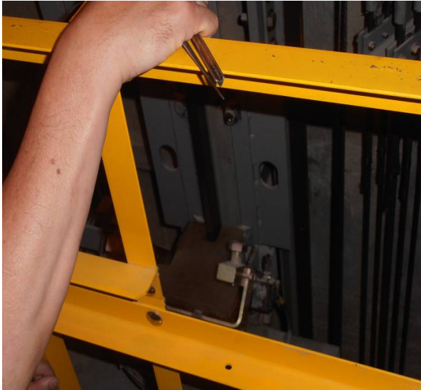
圖 70 工作平台護欄的半高位置附近有橫欄
