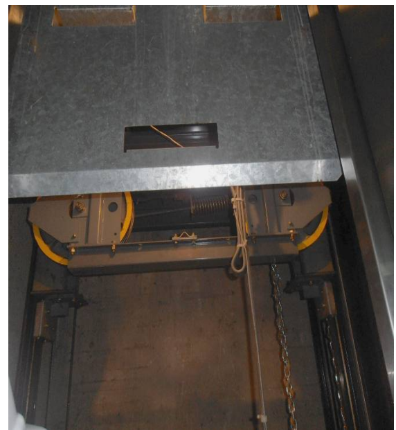
圖 33 鋼索經過車廂底的情形
