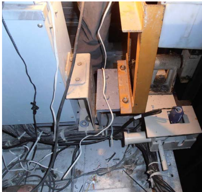
圖 64 鋼栓有感應器連鎖到控制電路
