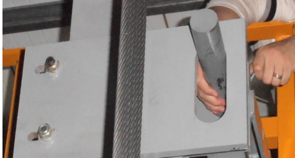
圖 24 車廂另備有一機械式鋼栓
