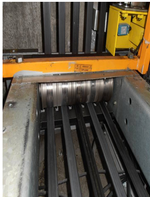
圖 75 車廂的懸吊是從車廂頂
