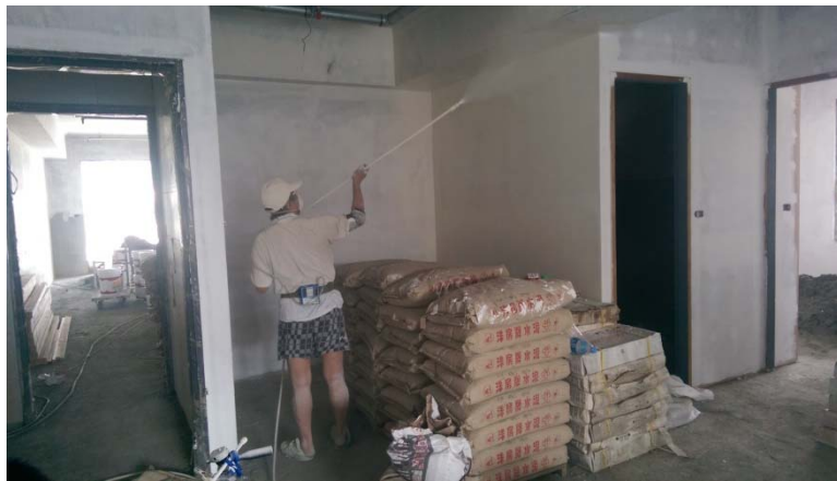
圖 36 大樓新成屋之室內牆面噴漆作業
