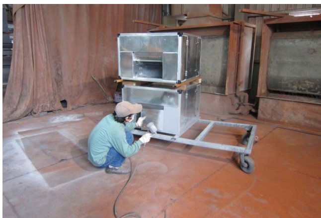
圖 40 通風設備廠之物件面漆噴漆作業
