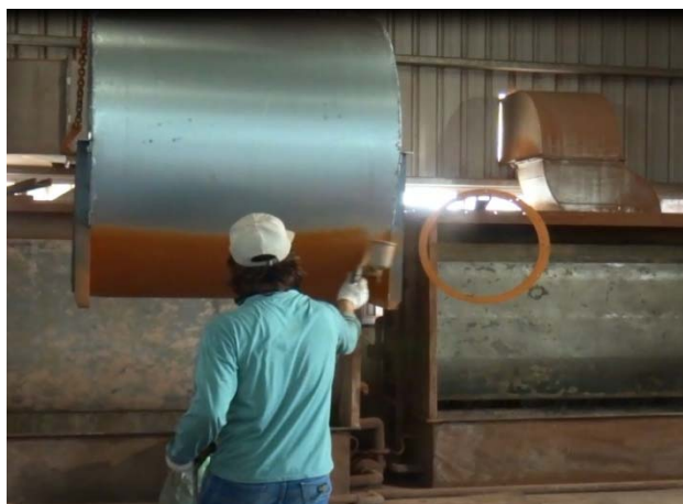
圖 41 通風設備廠之物件防鏽噴漆作業
