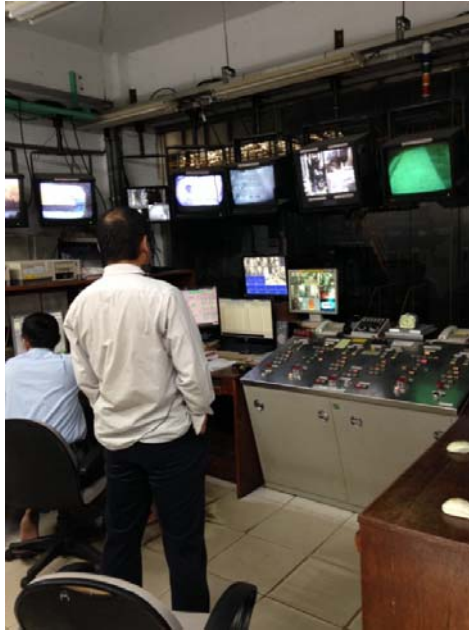
圖 56 作業人員於控制室內操作設備
