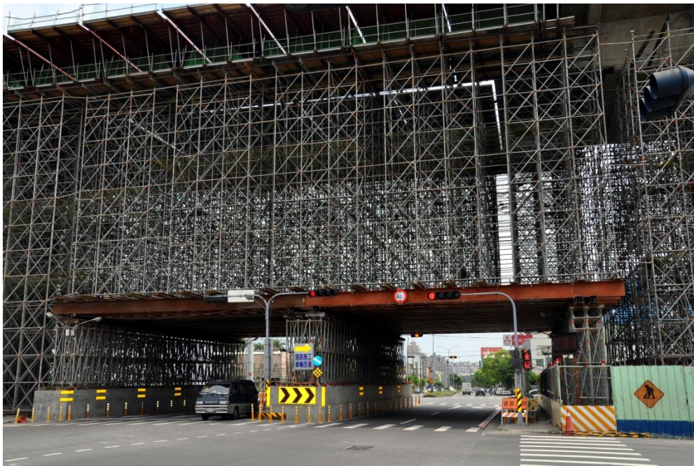
圖 36 系統支撐架用於跨路面工程
