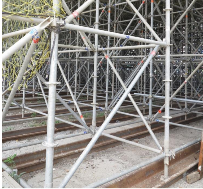
圖 59 支撐架底設置鋼軌（示意圖）
