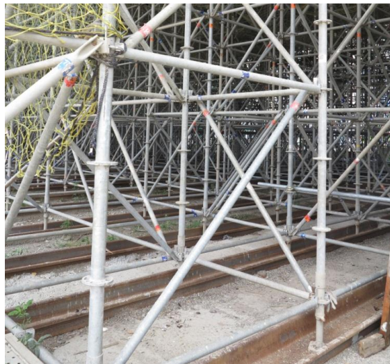
圖 22 支撐架底設置鋼軌（示意圖）
