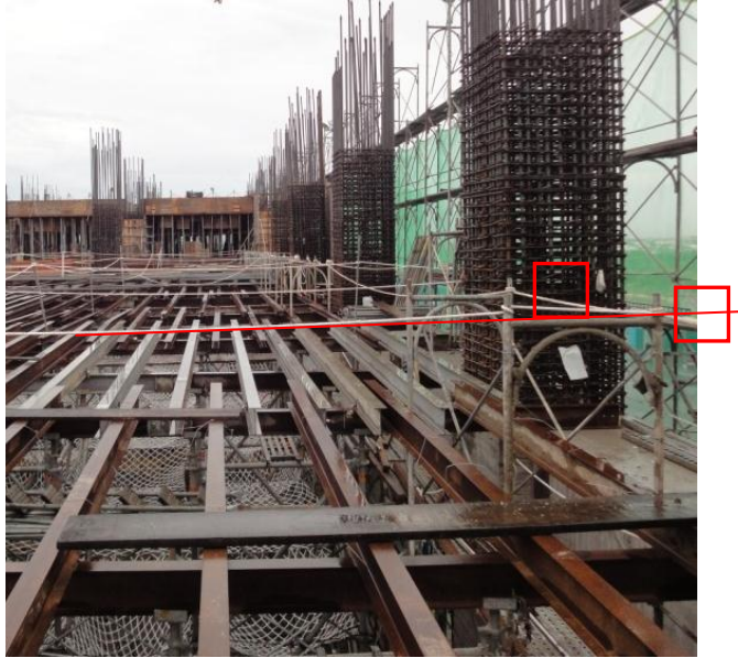
圖 47 安全母索材質及設置方式不適當
