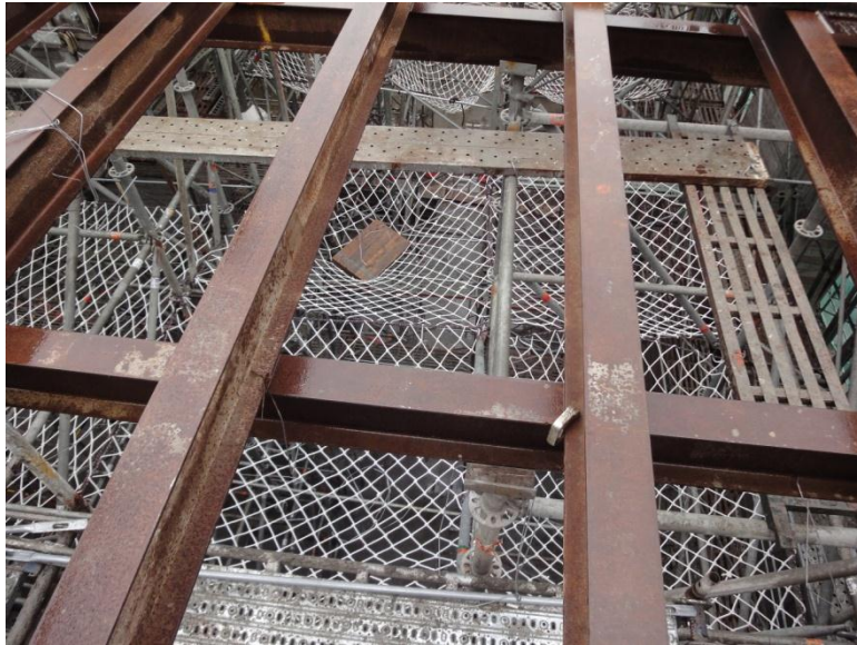
圖 31 以原有之施工架作為支撐架之上下設備及施工通道
