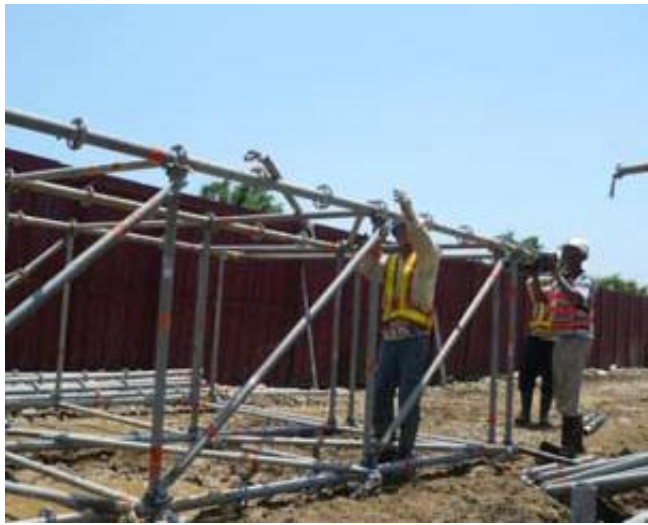
圖 42 於地面組裝系統式支撐架
