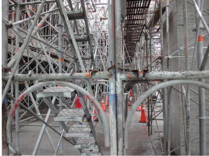
圖 31 以原有之施工架作為支撐架之上下設備及施工通道
