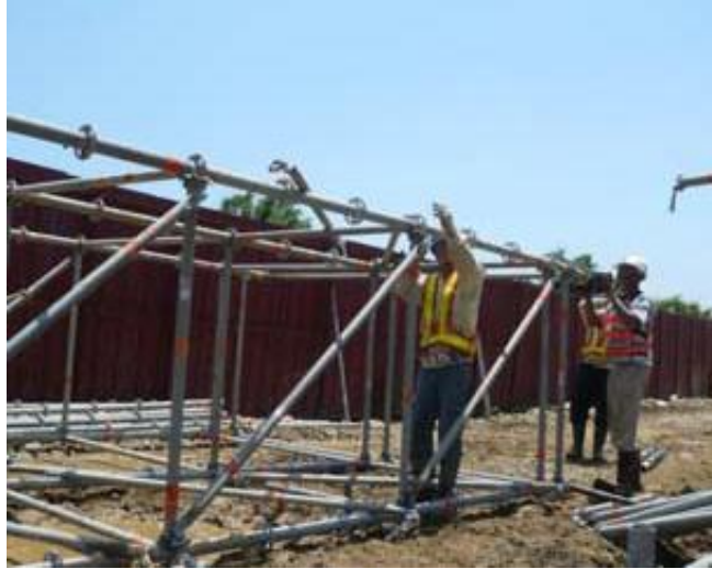
圖 27 於地面組裝系統式支撐架
