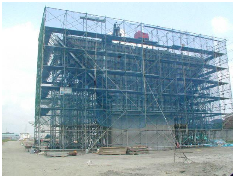
圖 40 橋墩下部工程中使用系統式支撐架
