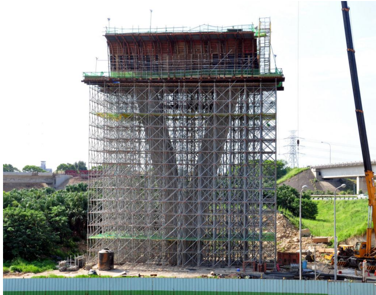
圖 13 特殊形式系統支撐架組搭完成後現地施工情形
