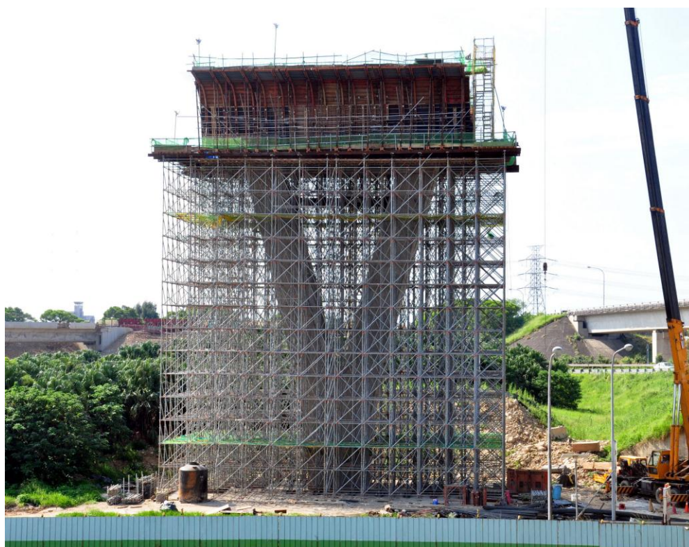
圖 50 特殊形式系統支撐架組搭完成後現地施工情形
