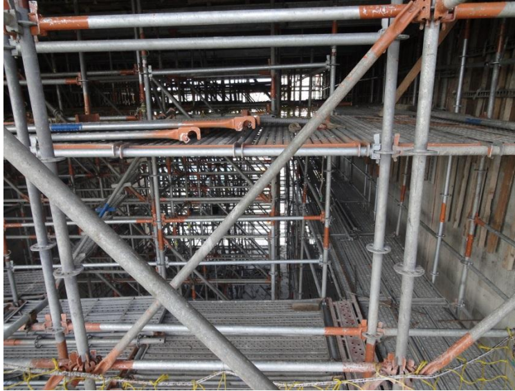
圖 10 施工現場之系統式支撐架
