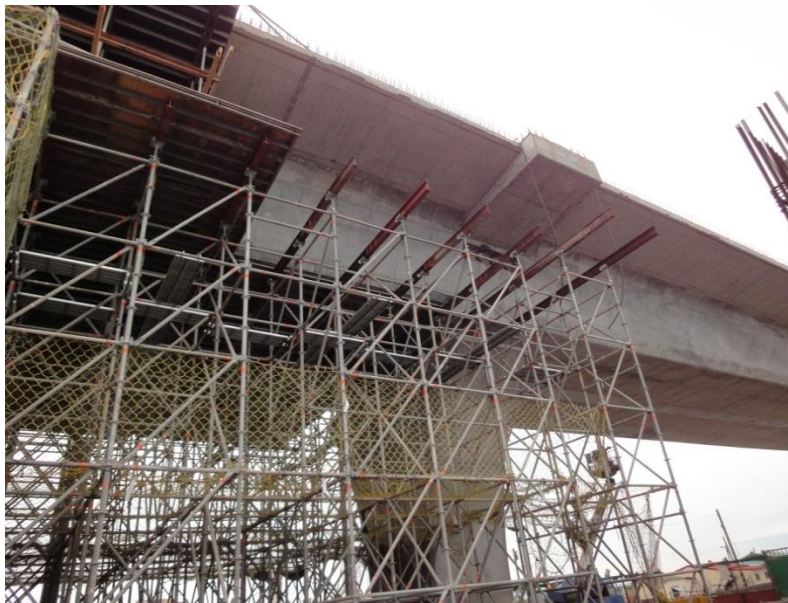
圖 34 系統支撐架用於大型公路橋梁工程
