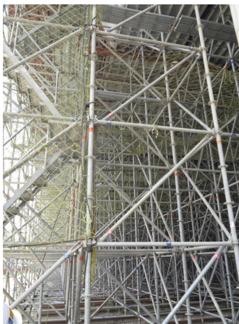
圖 29 支撐架中的上下設備及通道
