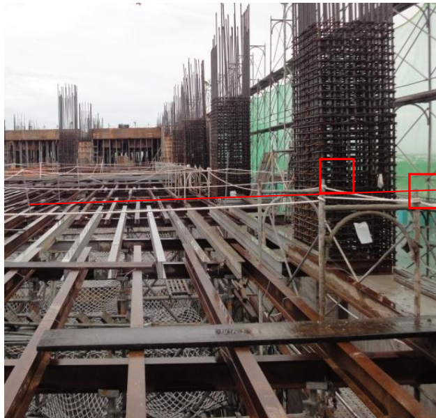
圖 10 安全母索材質及設置方式不適當
