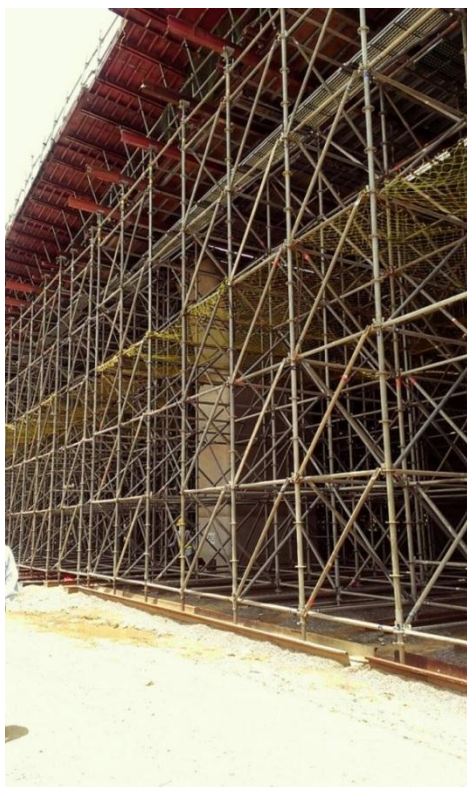
圖 26 系統式支撐架現場使用情形
