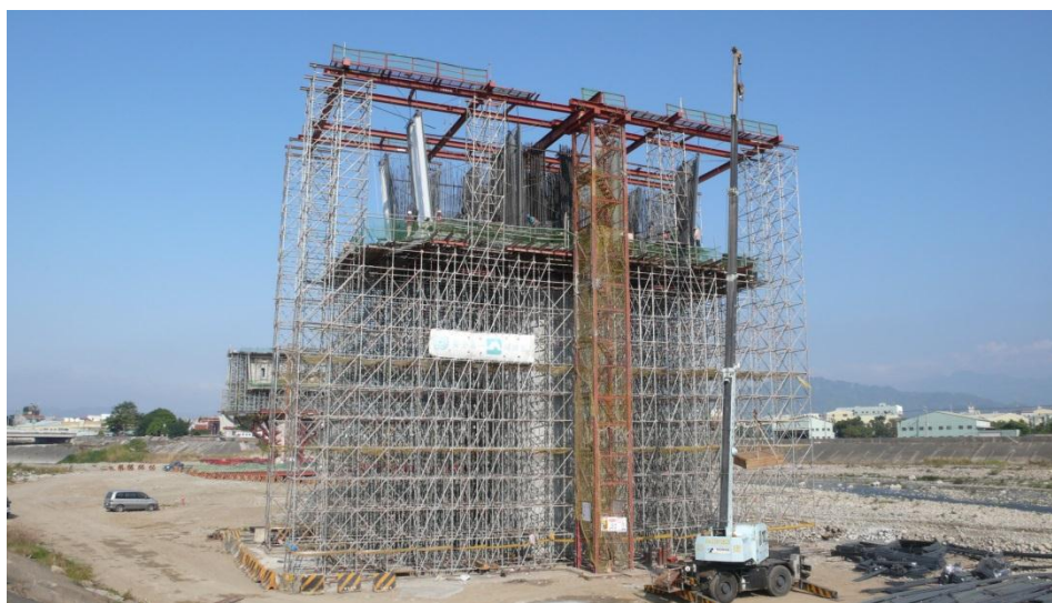
圖 37 特殊造型系統式支撐架
