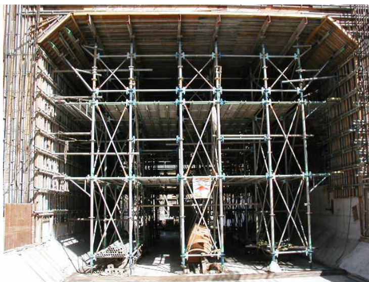
圖 38 箱涵中使用的系統式支撐架
