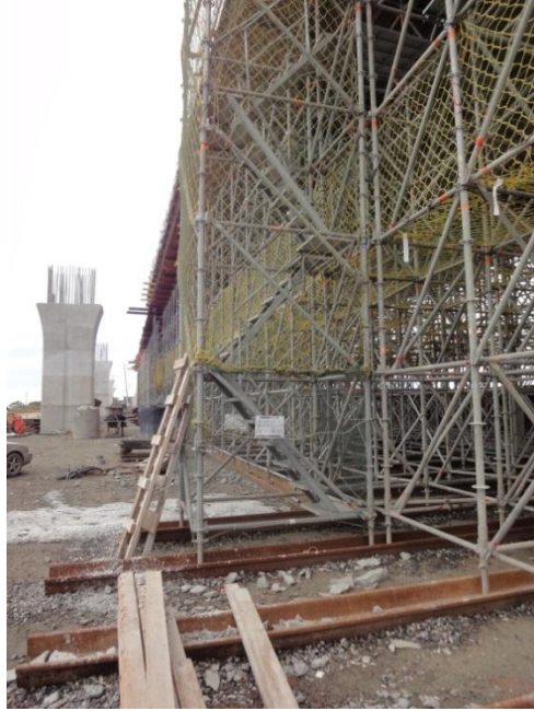
圖 35 上下設備設置於支撐架外
