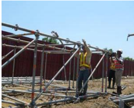
圖 5 於地面組裝系統式支撐架
