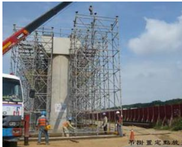
圖 27 於地面組裝系統式支撐架
