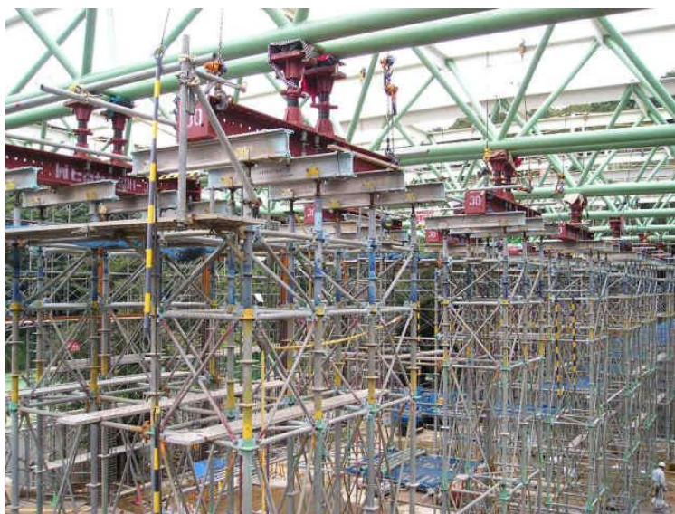
圖 39 鋼骨承載施工
