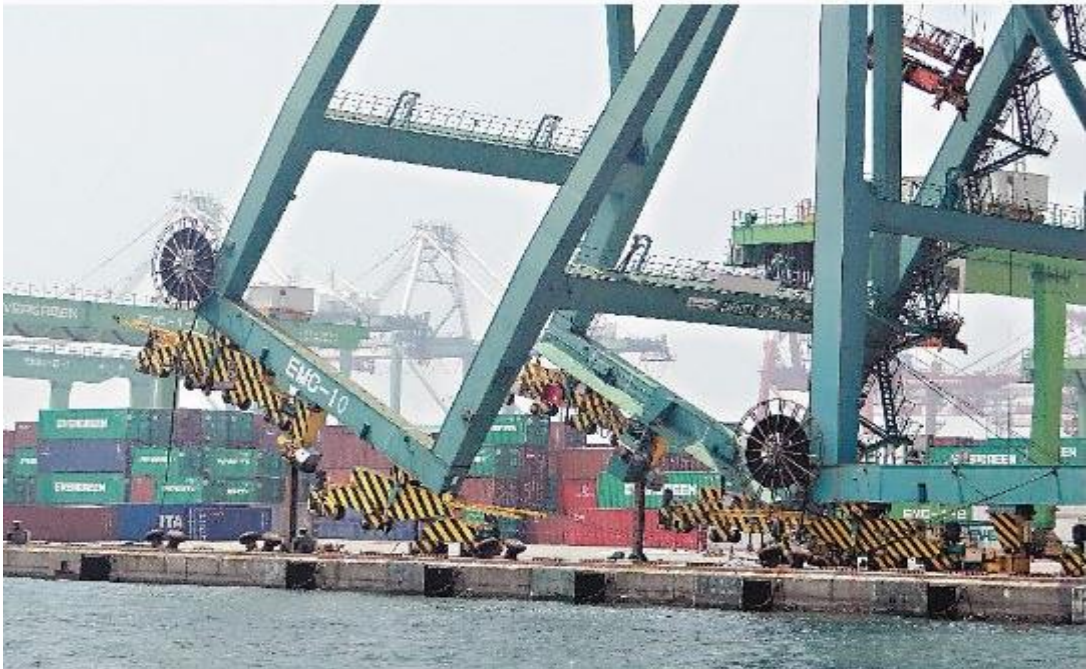
圖 1 風襲橋式集裝箱起重機
