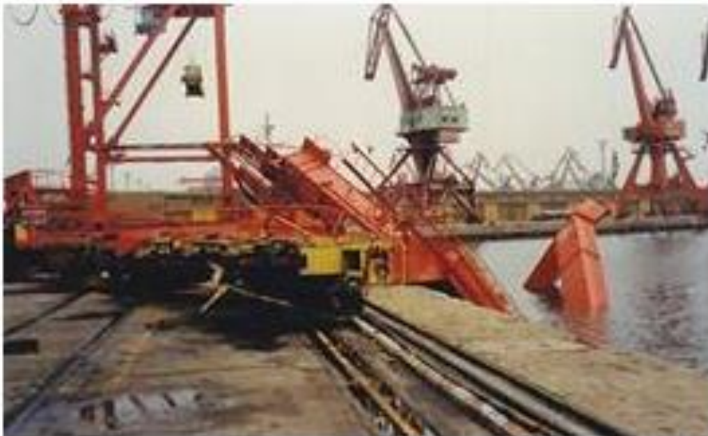
圖 5 風襲港口岸邊集箱裝起重機
