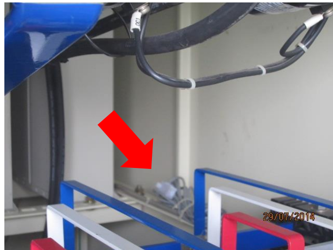
圖 52 廠家 D 配電盤內使用之弧光感測器
