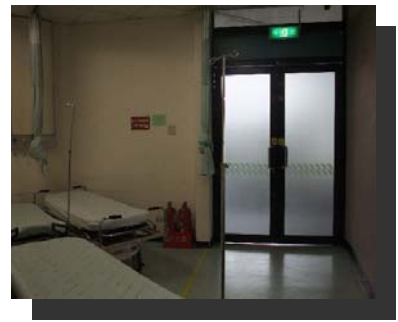
急診室內另外設置緊急逃生門
