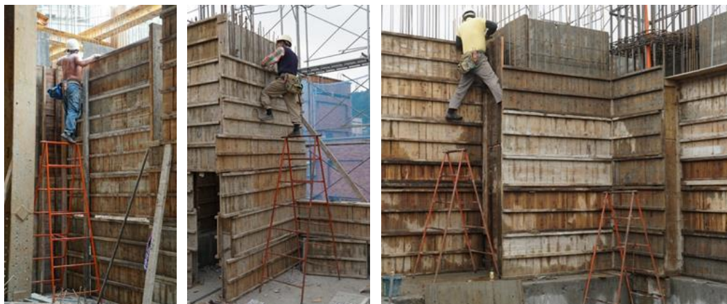
圖 52 民間建築工程模板工於牆模組立作業現況
