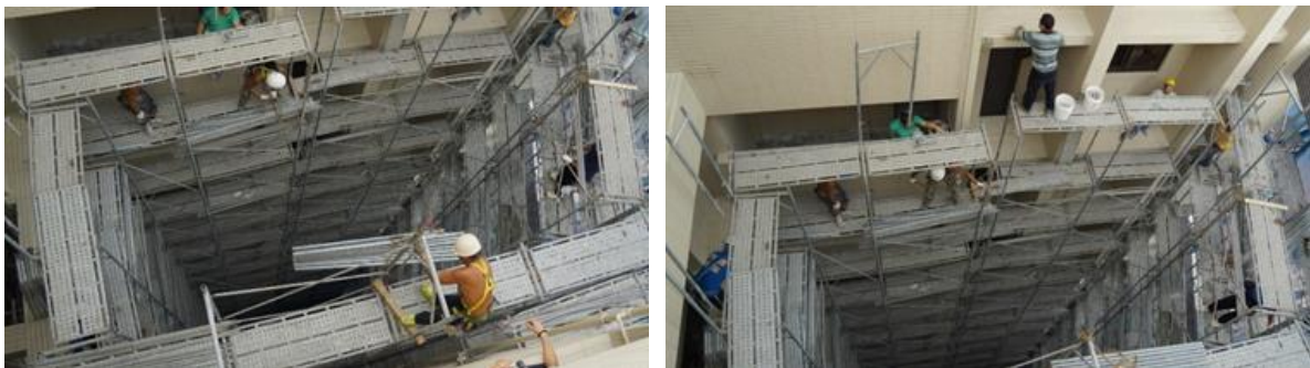
圖 50 民間建築案外牆拆架作業狀態
