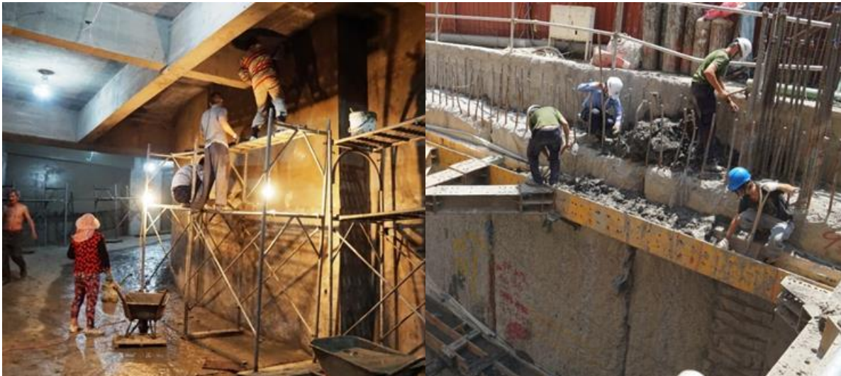
圖 28 泥作工室內粉刷與臨時工戶外清除泥塊作業實景
