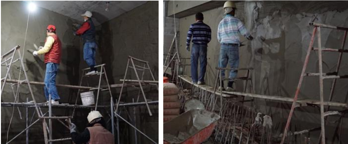
圖 49 民間建築案泥作工地下室與一般樓層粉刷作業狀態
