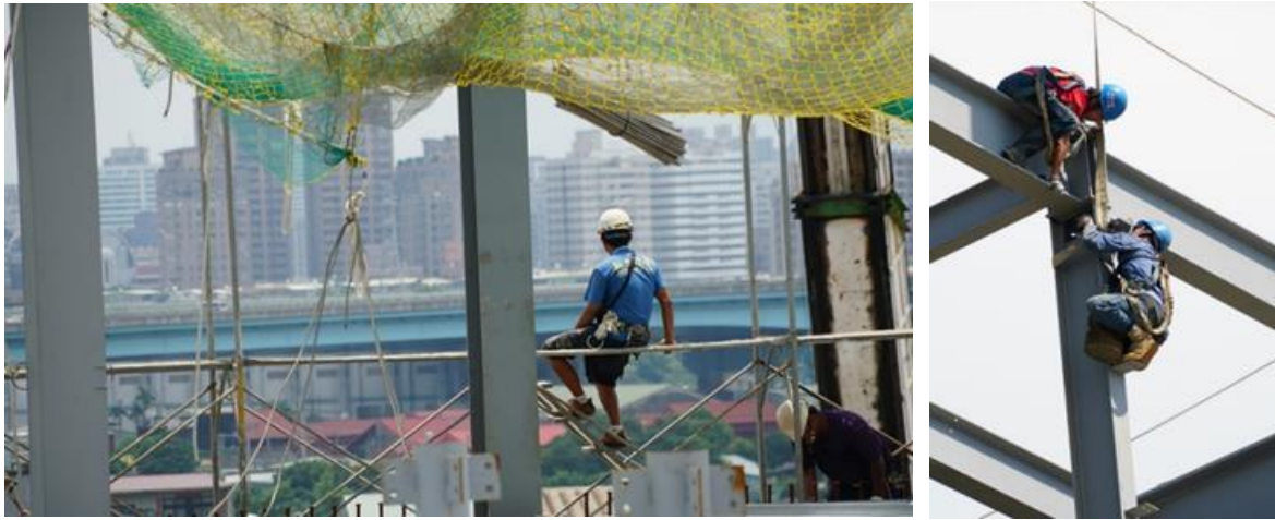
圖 51 民間鋼構建案外牆鷹架工與鋼構件組裝工作業狀態
