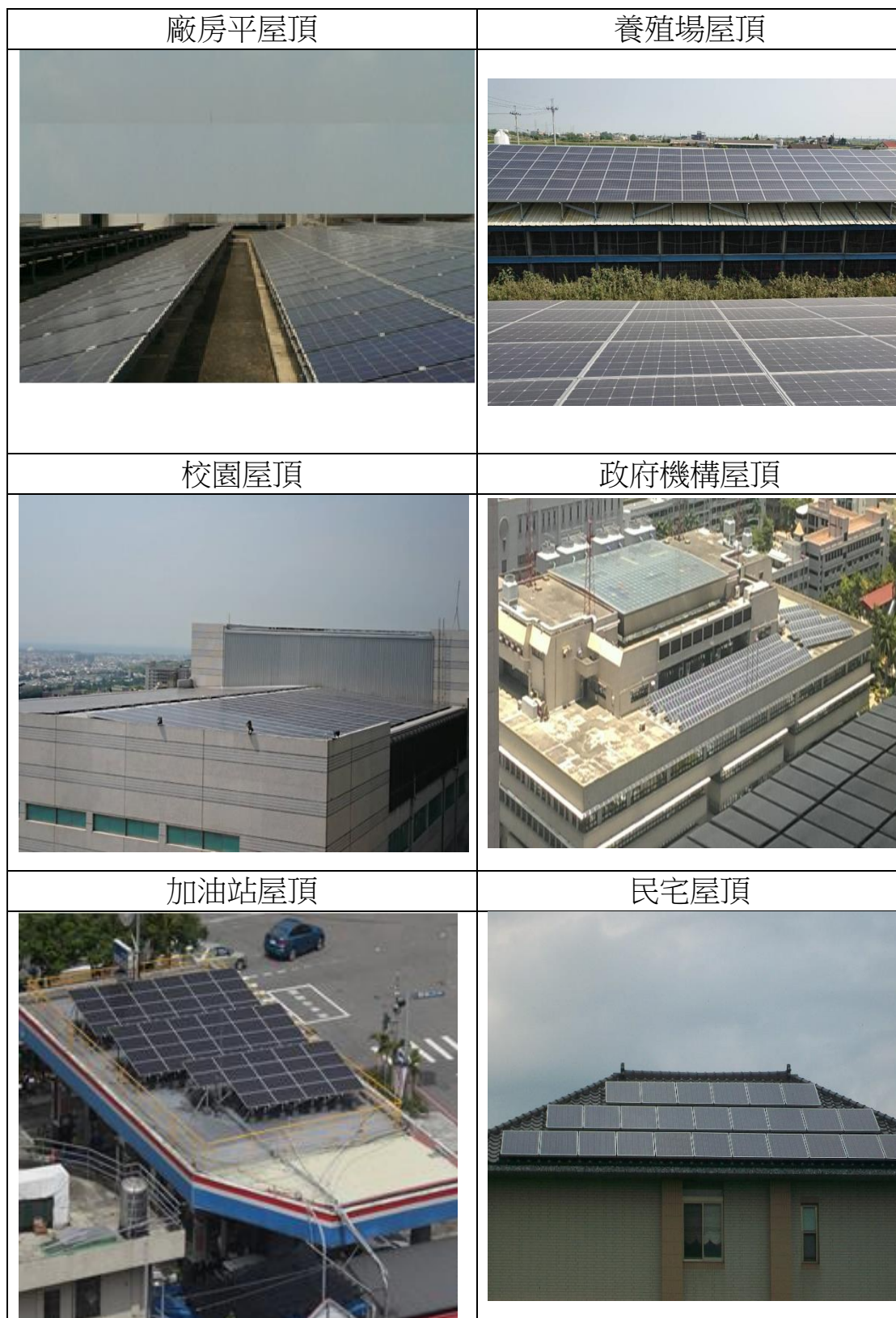
圖 9 各樣建築物上之太陽光電系統
