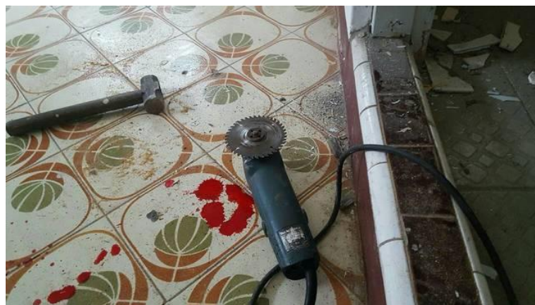
李姓工人裝潢浴室，砂輪機突然彈飛割傷手掌。
