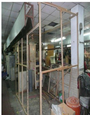
施作現場照片。
