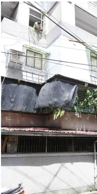
施作現場照片。
