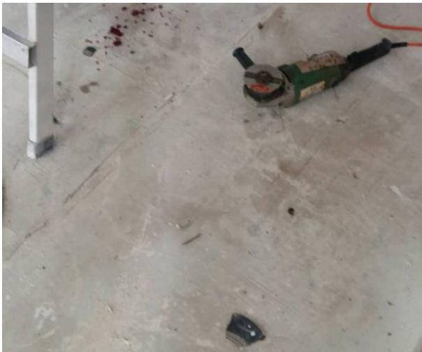
施作現場照片。
