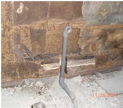
施作現場照片。
