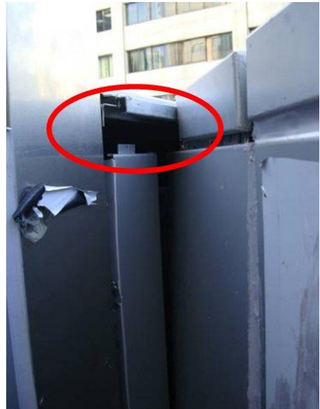
外牆露臺內封板處。
