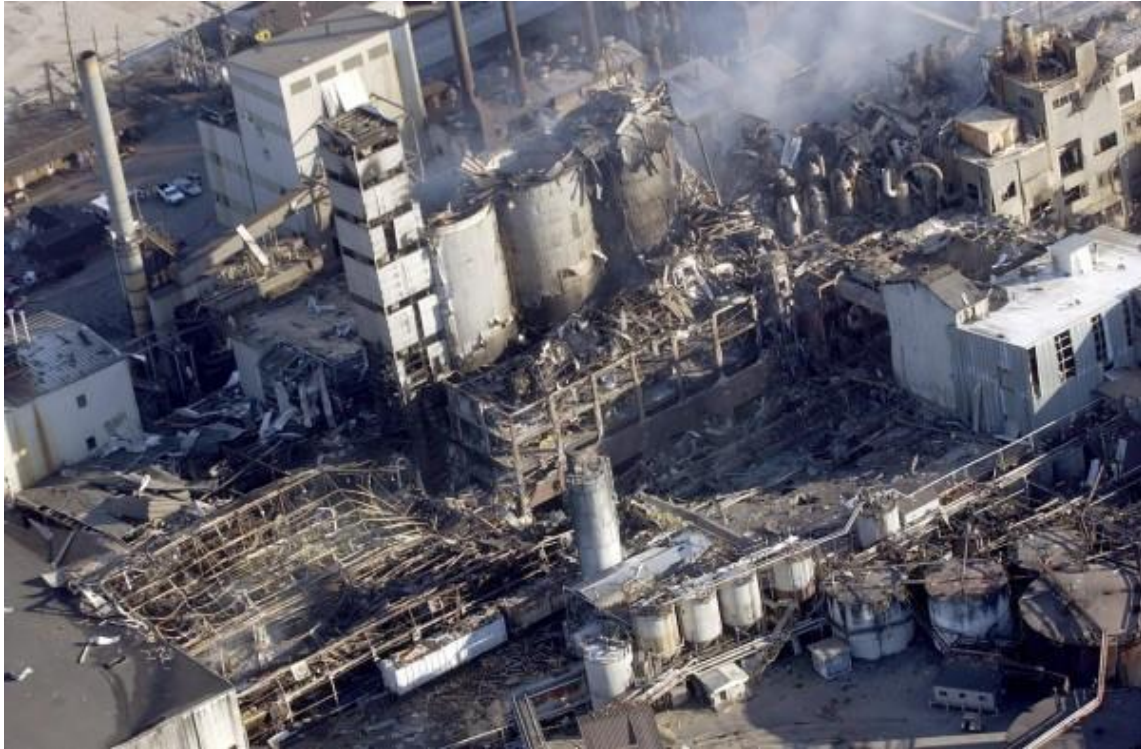
圖 8 2008 年 02 月 07 日美國喬治亞州某一製糖廠發生粉塵爆炸事故 [13]
