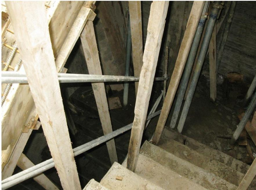
圖 13 木材模板支撐支柱設置情形
