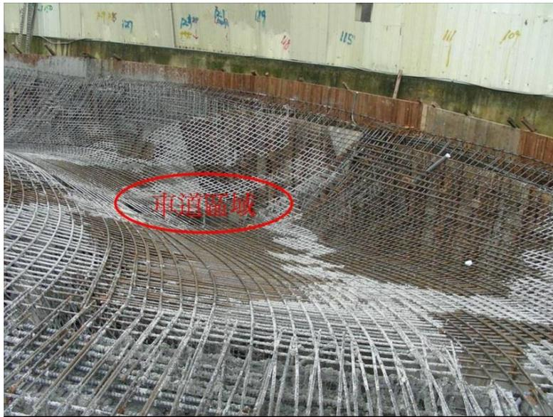
圖 7 模板支撐架倒塌災害現場
