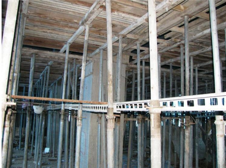
圖 11 可調鋼管支柱設置情形
