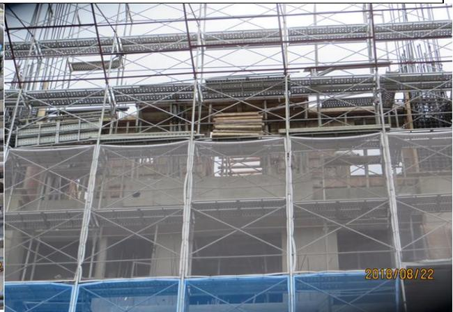
施工架上堆置物料有物體飛落及超載之虞
