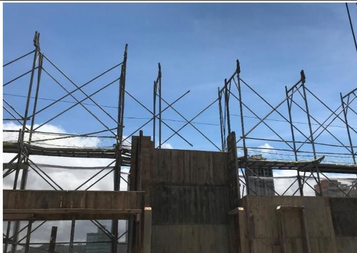
施工架頂層未設置扶手框，且部份交叉拉桿未固定
