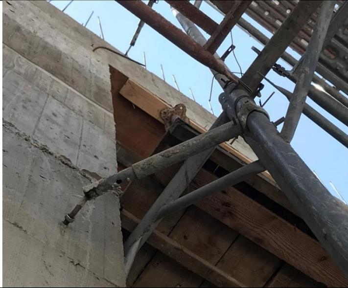
現場施工架採用預埋式制式壁連座
