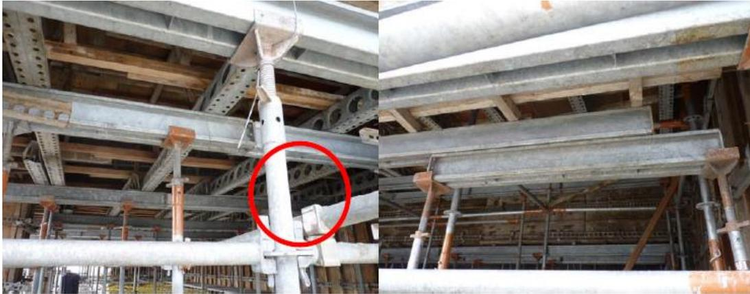
圖 8 模板支撐構件未以螺栓或金屬附屬配件固定
