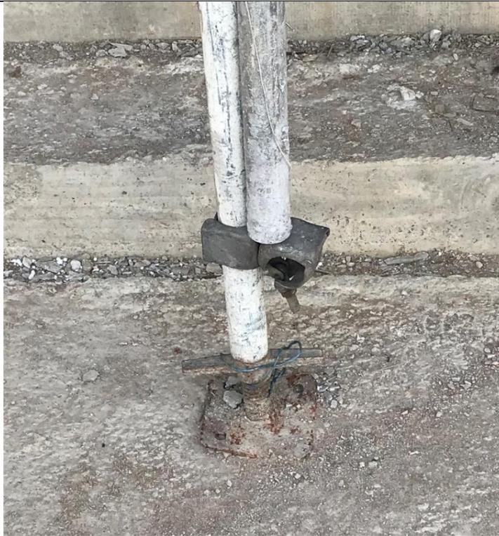
部份鋼管施工架基座已嚴重鏽蝕
