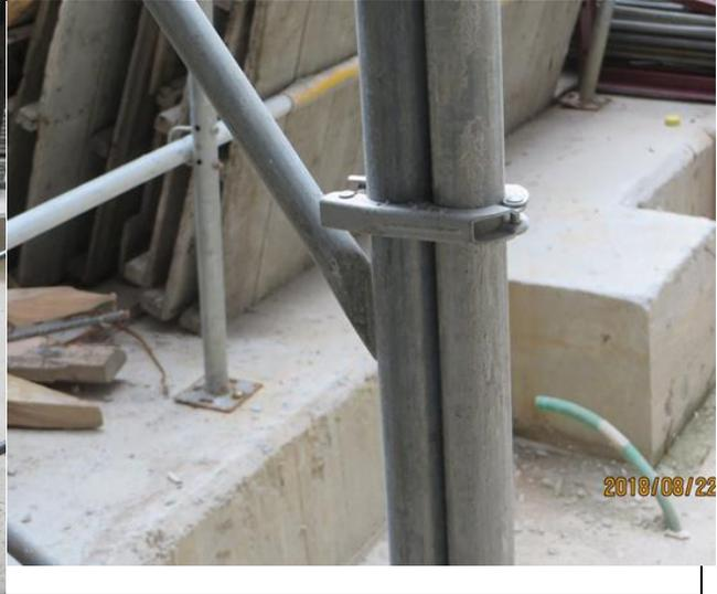
施工架立柱搭接有使用二個 8 字扣
