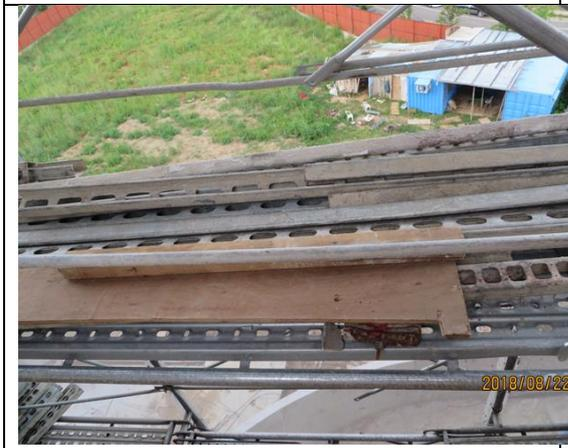
施工架上堆置物料超過每架之限制荷重，造成不均勻荷重及妨礙安全通路
