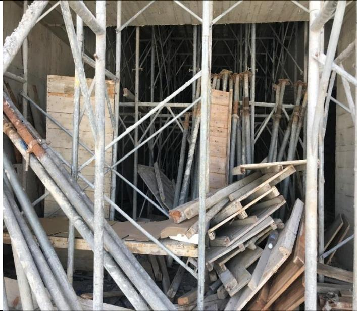
結構體作業通道堆放模板支撐之物料影響模板支撐及施工架之安全性
