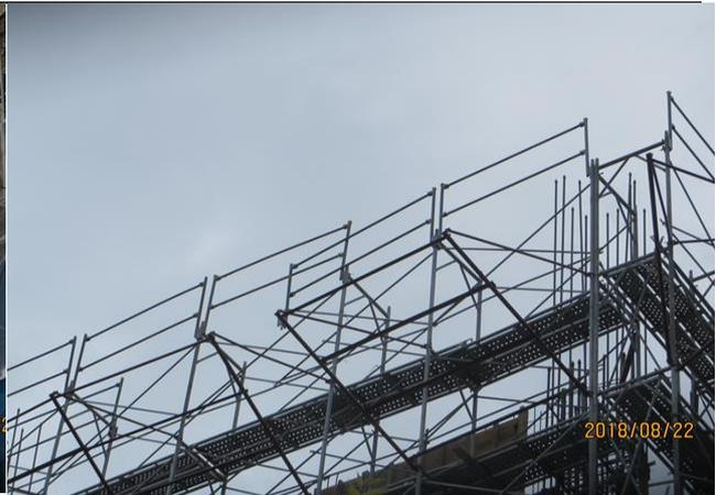
施工架合約雖為雙邊扶手先行工法，但部分為單邊，且依在和施工架廠商現場負責人私聊，其都是在最後搭完再放扶手架上去給人看，組拆架過程未使用（所以廠商問這扶手的用處為何）上下樓梯直上四架未轉折及未有加強防墜護欄建議可改善
