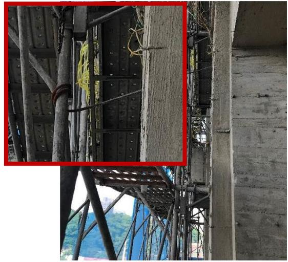
以鋼筋綁紮兩圈作為施工架繫牆桿
