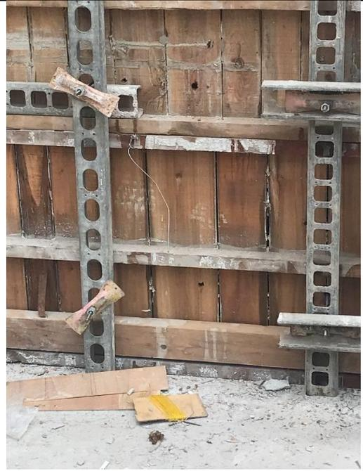
工程現場採用三層模固定，未按圖施工
