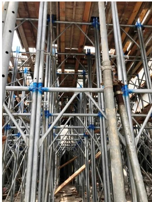
圖 12 鋼管施工架設置為模板支撐架
