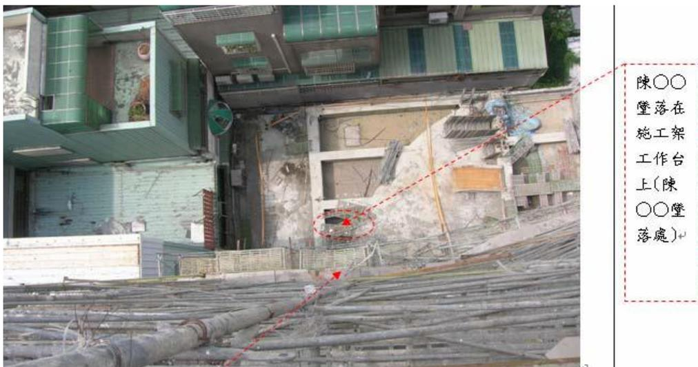
圖 5 勞工從事高處施工架拆除作業肇災
