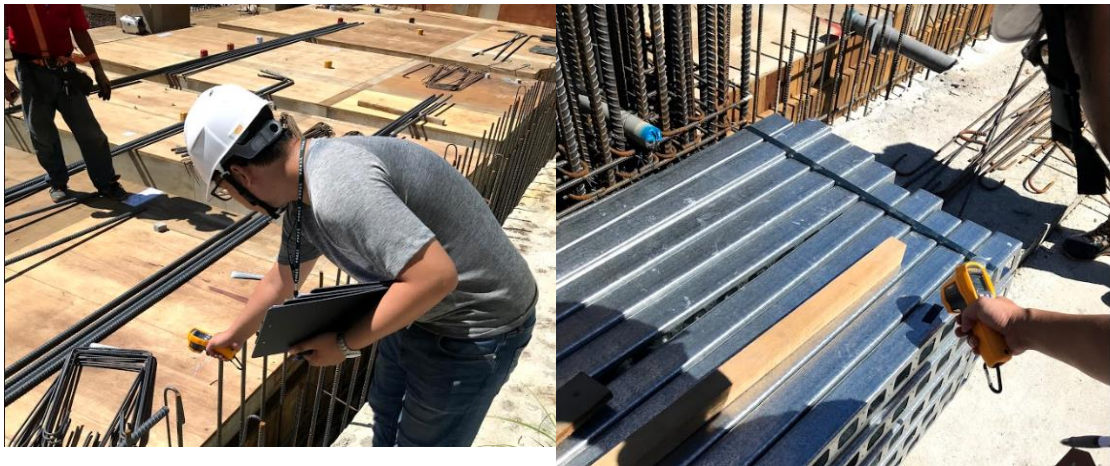
圖 15 現場實測勞工作業環境之物料溫度照片
