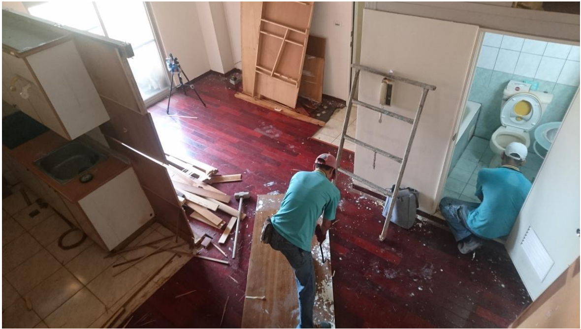
圖 42 使用手工具拆除木質裝潢隔間作業
