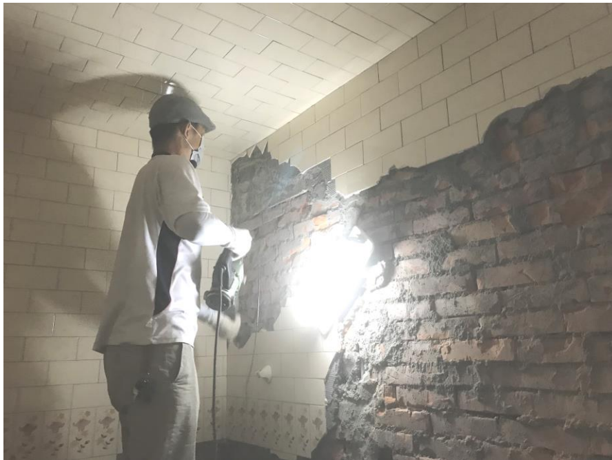
圖 2 磁磚拆除作業
