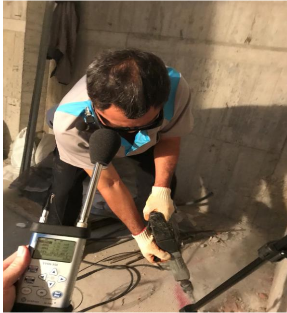
圖 18 勞工進行混泥土地面打除鑿孔作業
