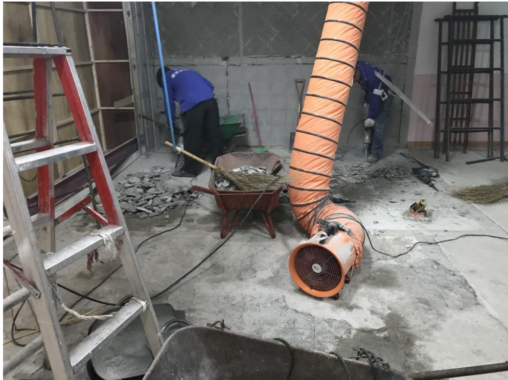
圖 36 混凝土地板打薄作業現場
