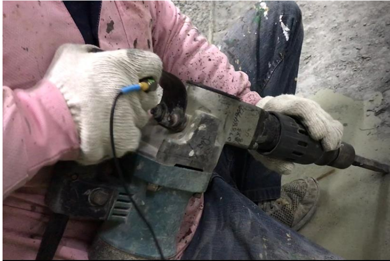
圖 33 使用電動鎚剷除混凝土及 PU 表面
