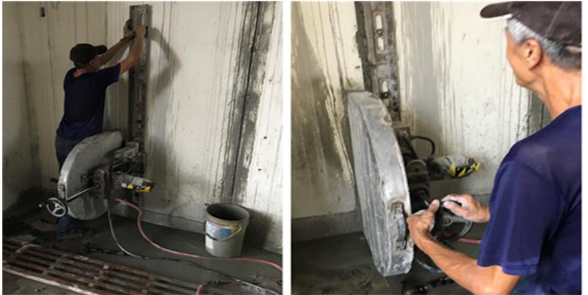
圖 46 混凝土牆面濕式切割作業
