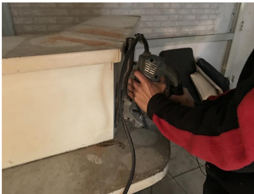
圖 31 勞工使用線鋸機切割、拆除木製吧檯作業
