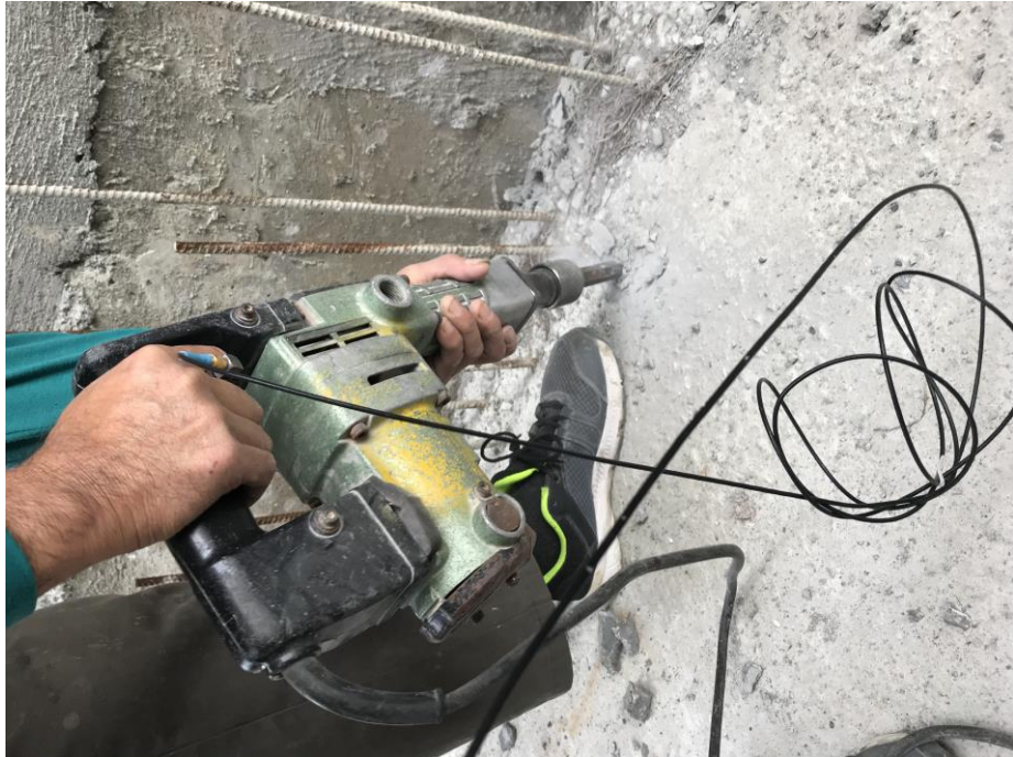
圖 16 作業現場 4 勞工進行混泥土地面鑿孔作業
