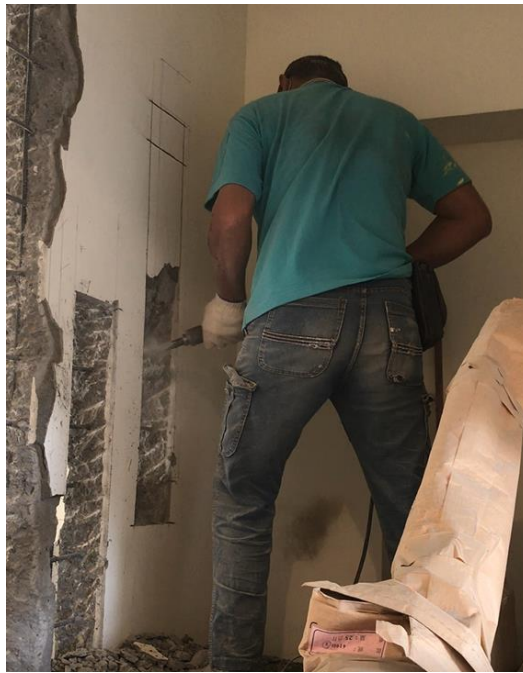
圖 3 混凝土牆面拆除作業
