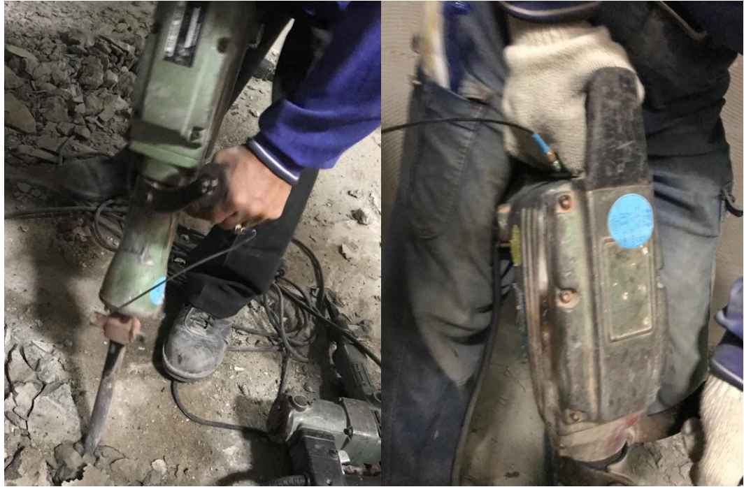
圖 38 混凝土樓板打薄作業勞工手部振動量測
