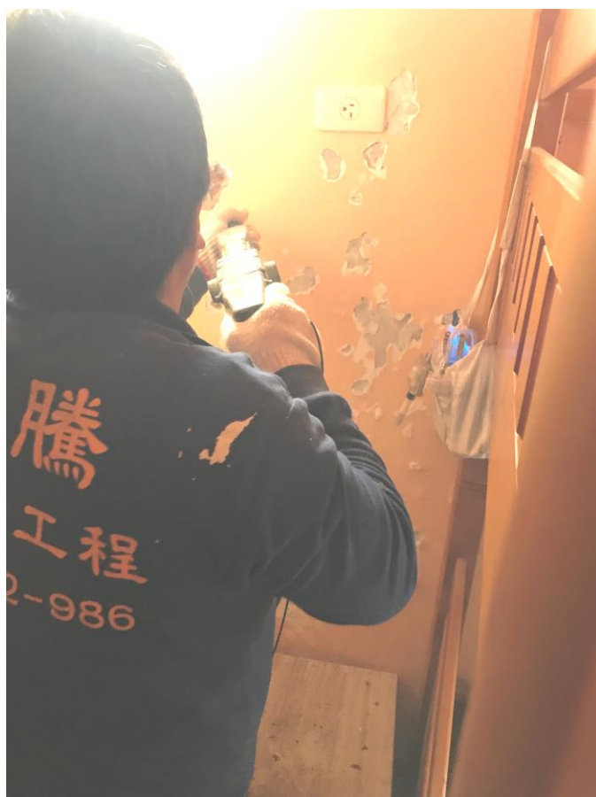
圖 20 勞工進行牆面鑿溝作業
