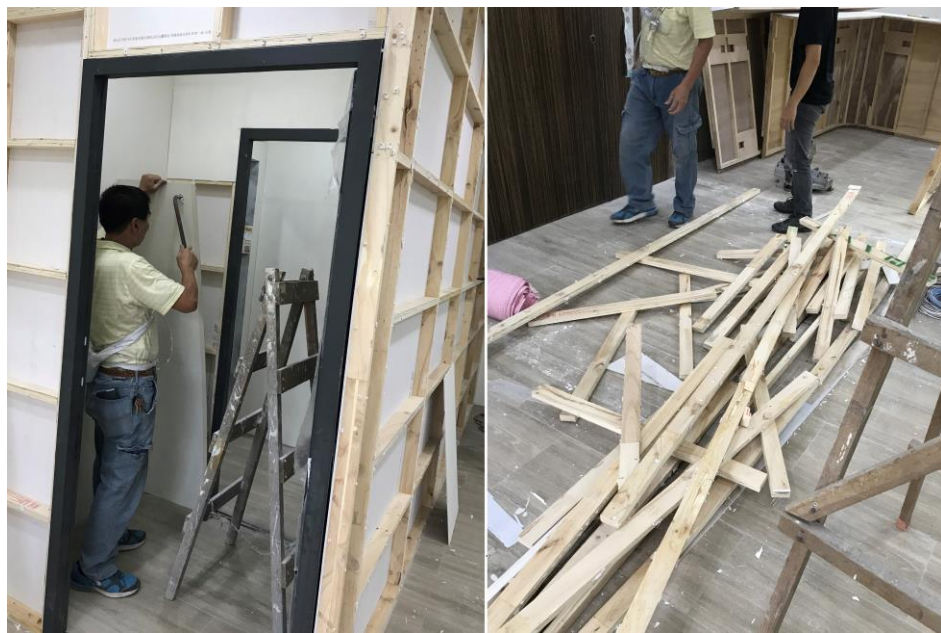
圖 44 使用手工具拆除矽酸鈣板隔間
