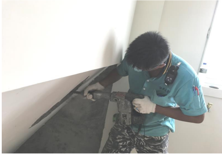
圖 14 混凝土牆表面剝除作業
