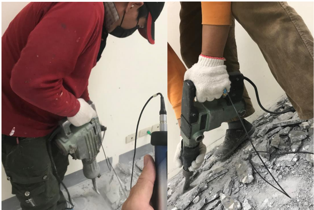
圖 23 作業現場 7 勞工作業情況及振動量測
