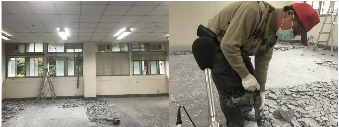
圖 22 磨石子地面敲除作業現場以及作業樣態
