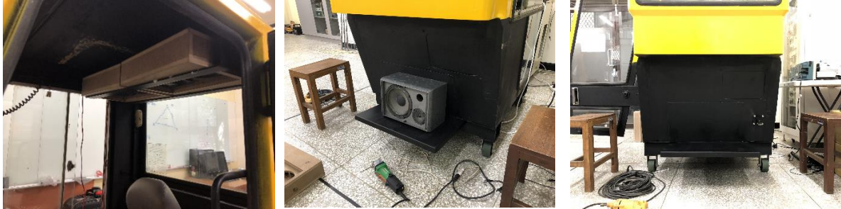
圖 20 挖土機車廂 ANC 元件定位
