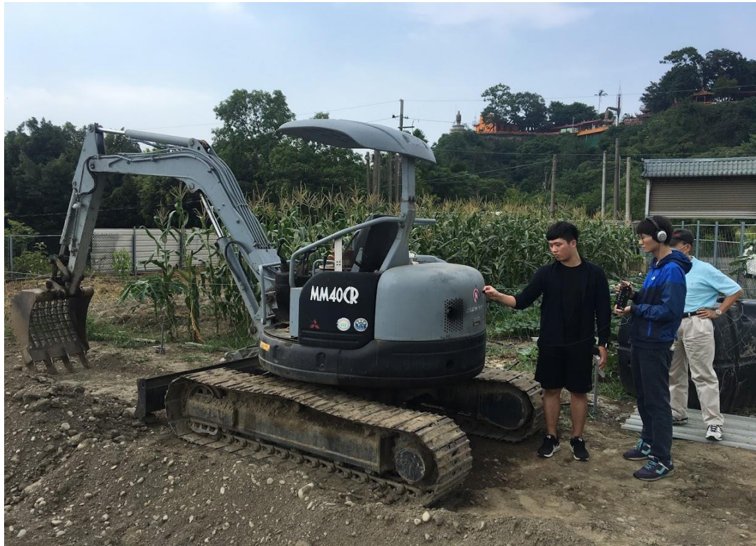
圖 6 挖土機引擎噪音量測
