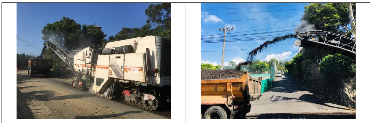
圖 7 刨路工程作業現場圖
