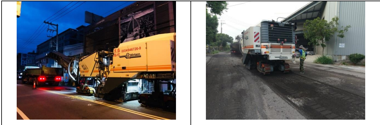
圖 7 刨路工程作業現場圖(續)
