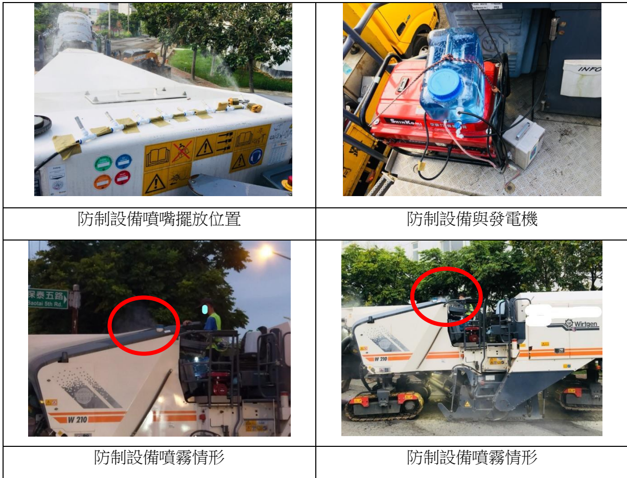
圖 11 模組 1 水噴霧系統於實際刨路應用
