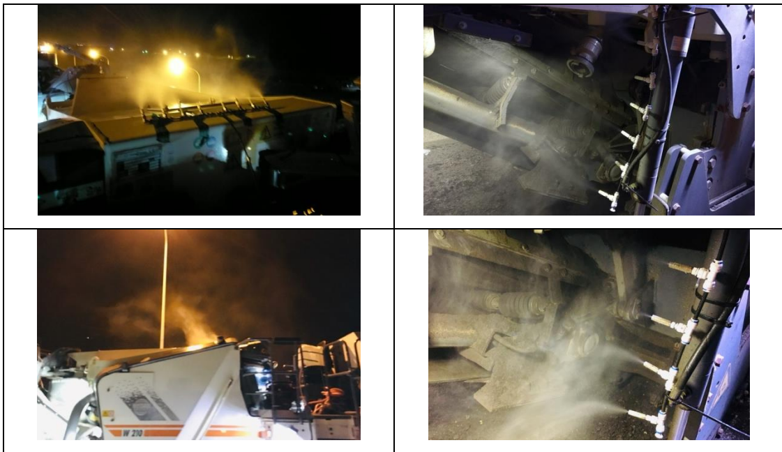
圖 13 模組 2 水噴霧系統於實際刨路應用
