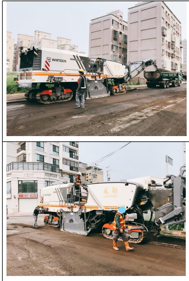
圖 3 現場刨路作業圖
