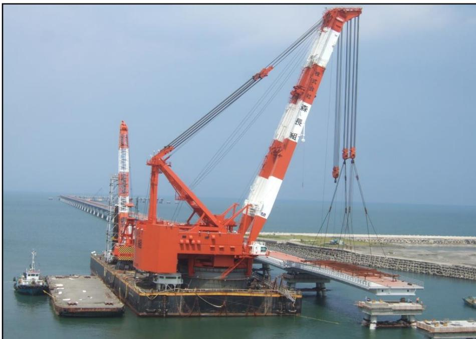
圖 24 60M 大跨度箱型鋼梁海上吊裝實景
