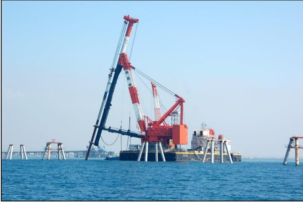
圖 25 鋼管樁海上打設實景
