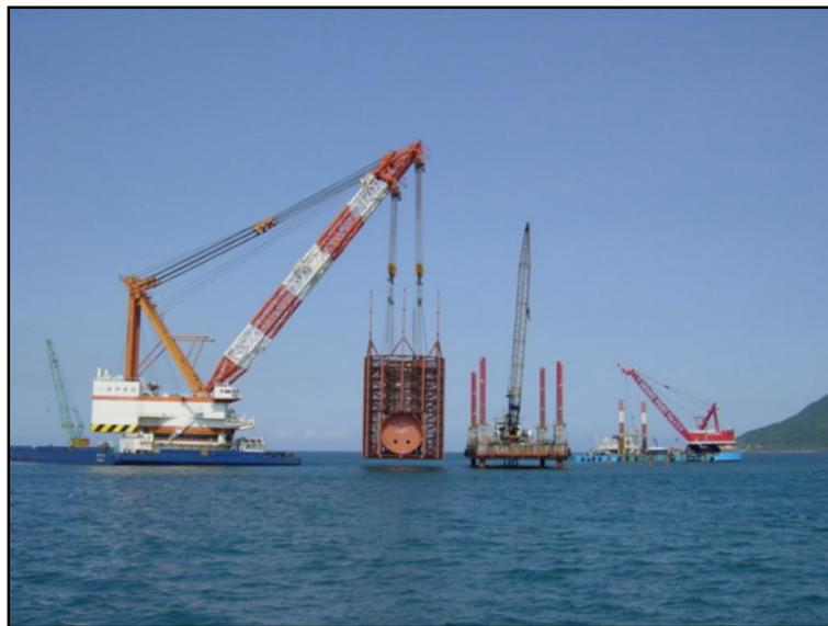
圖 27 肘管海上吊裝實景(使用全回旋起重機船)
