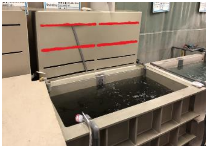
圖 56 改善前電鍍槽排氣孔開口未遮蔽
