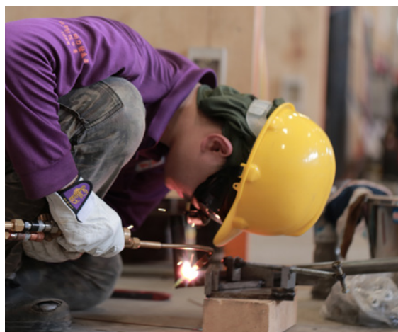
▲中彰投分署開設「室內水電技術班」訓練情形
