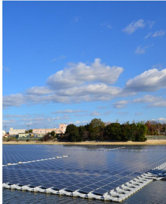
▲ 圖3 水面浮力式太陽能板
